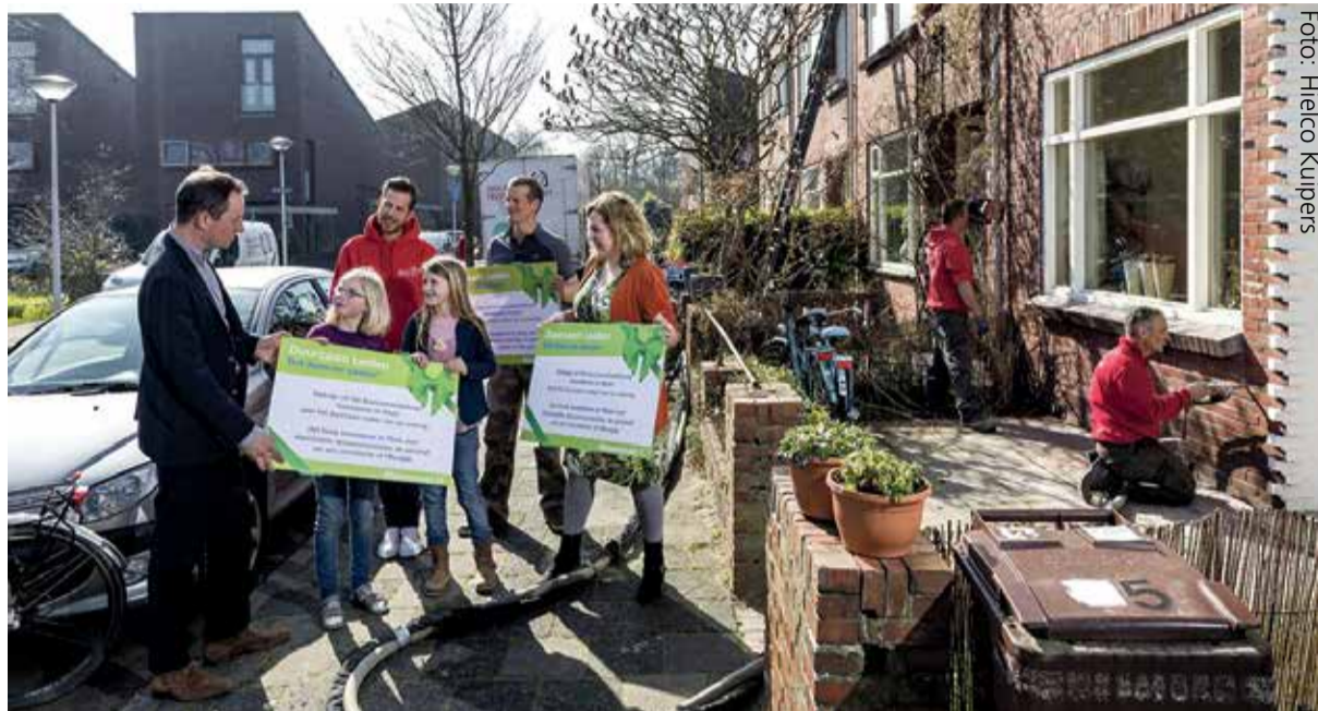
Bewoners van de Mezenstraat ontvangen uit handen van wethouder Frank de Wit een bijdrage voor het aanbrengen van een spouwmuurisolatie in hun woning. Dit wordt uitgevoerd door Isolatietechniek Best.
